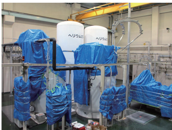
図1 工事準備中の液化機と周辺機器。
