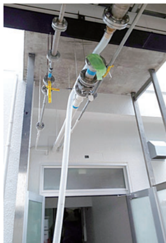
図4 装置開発棟入口の仮設配管繋ぎ込み。
