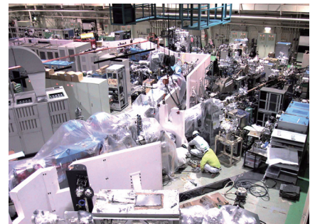
遮へい設置工事の様子
