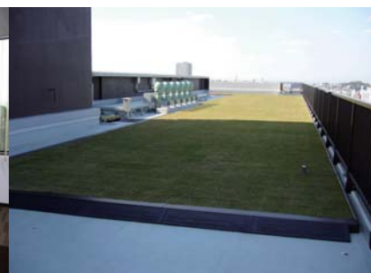
屋上緑化。 芝を植え自動散水装置も設置されている。
