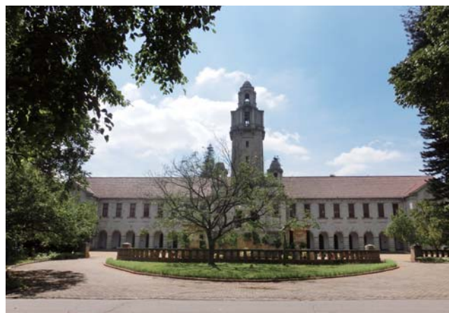
Indian Institute of Scienceの象徴的建物であるTower Building
