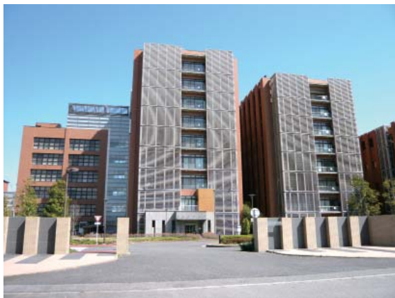
図1 現在の山手地区山手4号館（左） 設立当時は、正門は無く山手3号館（中央）は建設中で 周辺は未舗装であった。
