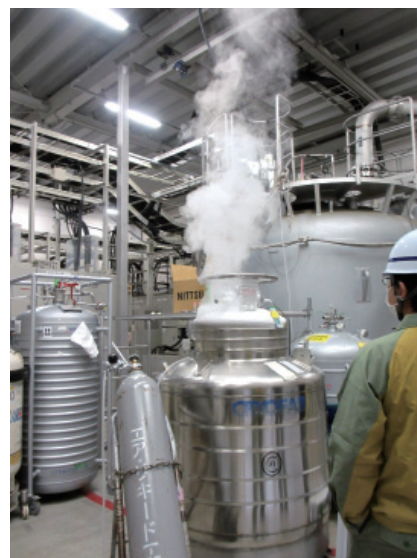
図3 作業風景。大気開放での充填のため、蒸発したヘリウムが立ち昇る。
