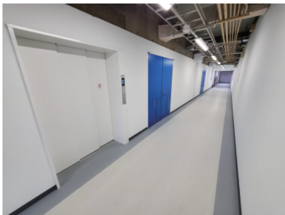
共同研究棟A棟（旧極低温棟）人荷共用エレベーター。
