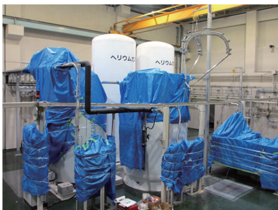
図1 工事準備中の液化機と周辺機器。
