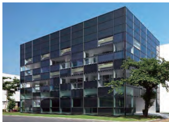
図1 半透明な有機太陽電池を窓に設置したビル。
