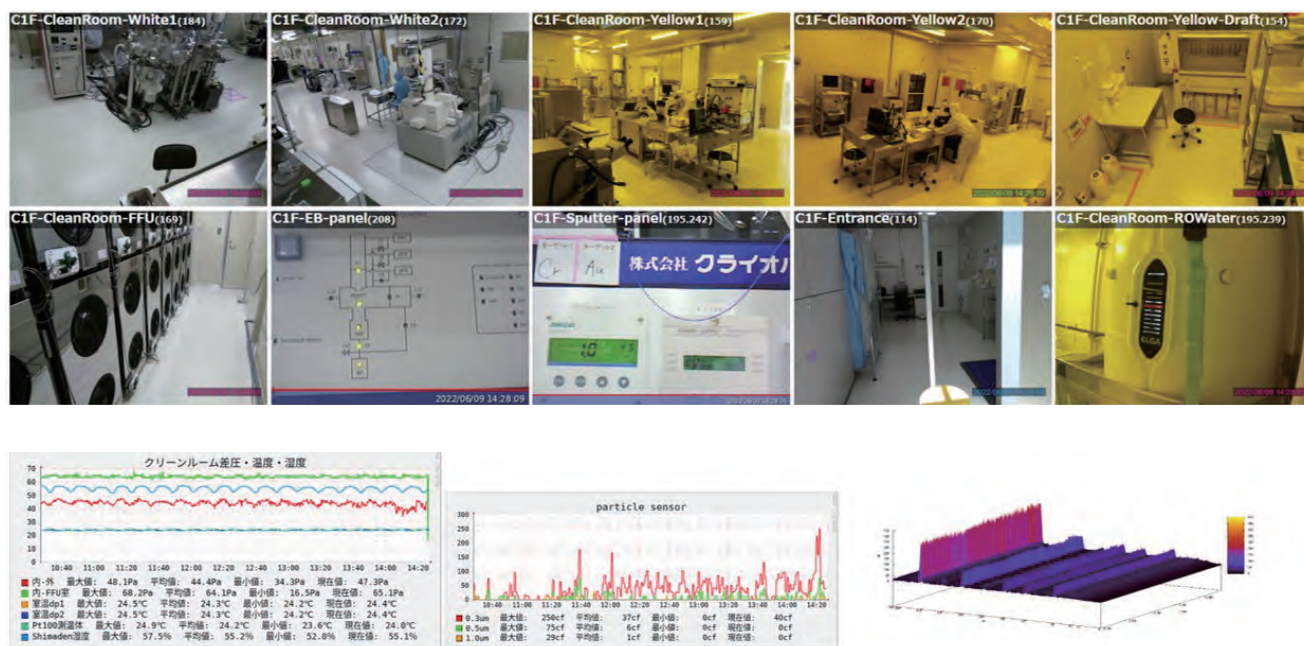
図4 クリーンルーム内の状況をリアルタイムでモニタしている 上2段：各箇所に設置されたカメラの画像 下左：差圧・温度・湿度、下中：パーティクル量、下右：ノイズ
