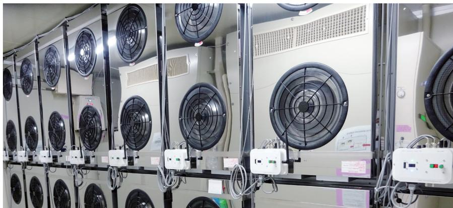
図2 C棟クリーンルームで稼働中のFFU制御ユニットV2
